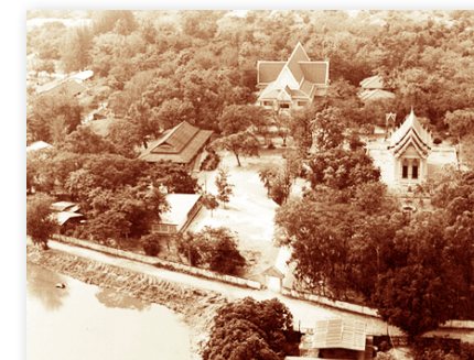
▲ ภาพถ่ายทางอากาศ ณ วัดป่าศาลวัน จ.นครราชสีมา
